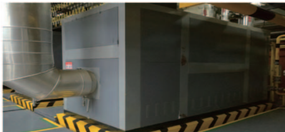
鍋爐、空調改造項目
